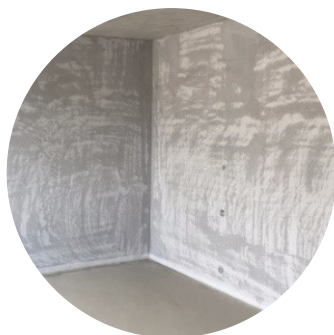
Beispiel: Backsteinwand mit Grundputz
