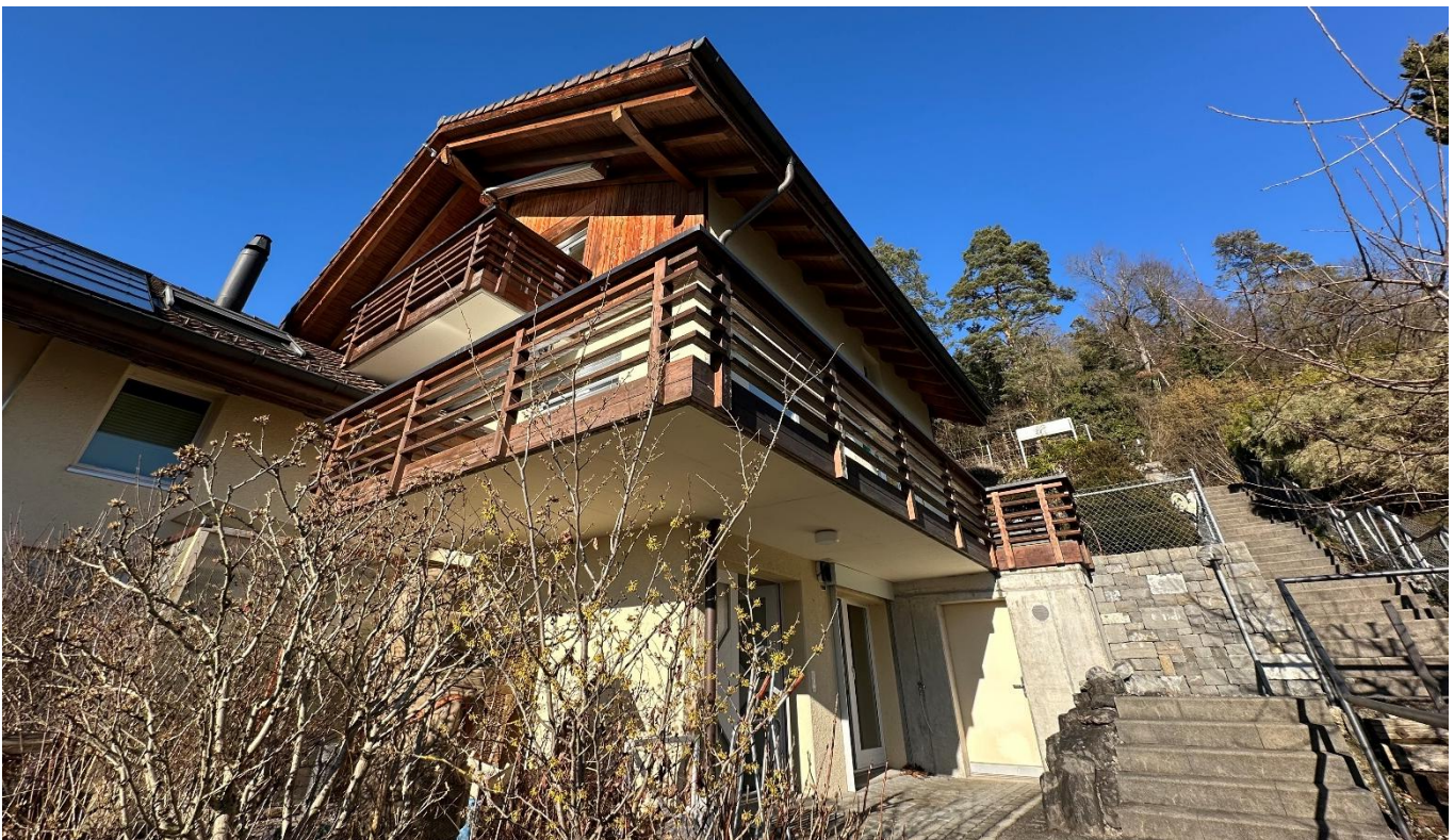
Charmantes einseitig angebautes 6 ½ Zimmer-Einfamilienhaus an sonniger Lage
