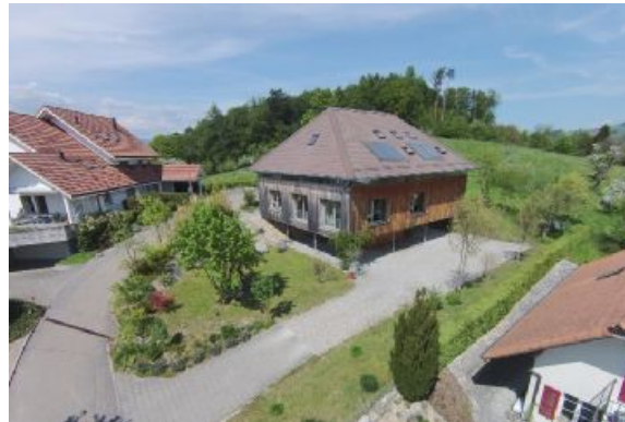
Südansicht der Liegenschaft
