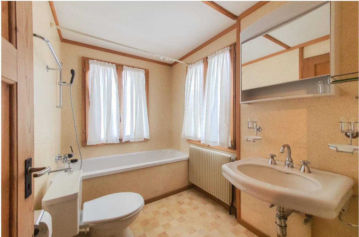
Das Badezimmer mit Wanne/Duschvorrichtung, Toilette und Handwaschbecken
