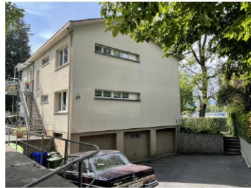
Bestand, Ansicht Nord-Ost
